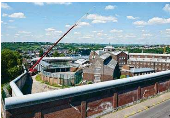
L'aile des prévenus sera évacuée puis détruite en décembre.
