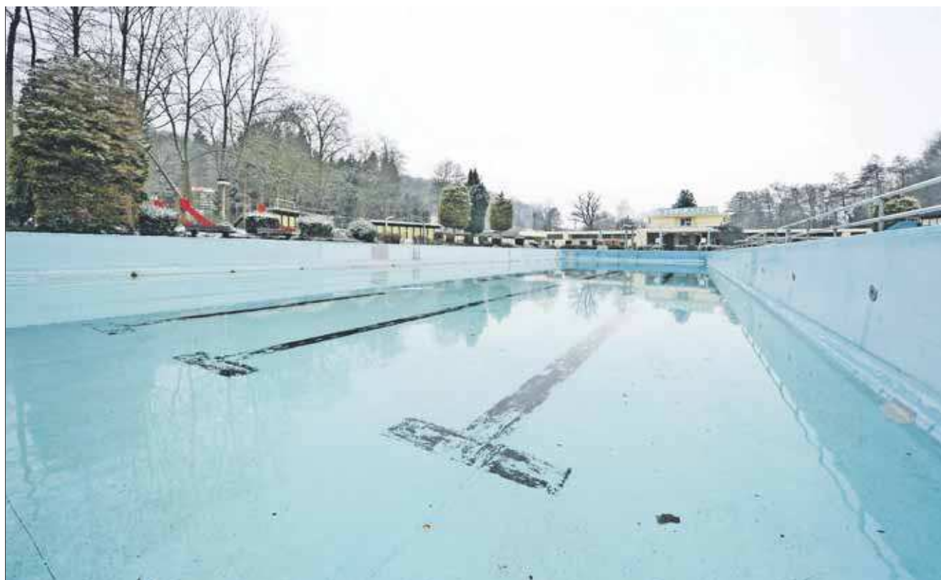
Das Regenrückhaltebecken wird im alten Außenbecken des Wetzlarbades (Foto) angelegt und somit in die bestehende Bausubstanz integriert werden. Archiv-Foto: David Hagemann
