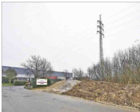
Die neue Straße soll neben der Polstermöbelfabrik Rom beginnen und bis unterhalb des Klosters Garnstock verlaufen. Foto: GE-Archiv
